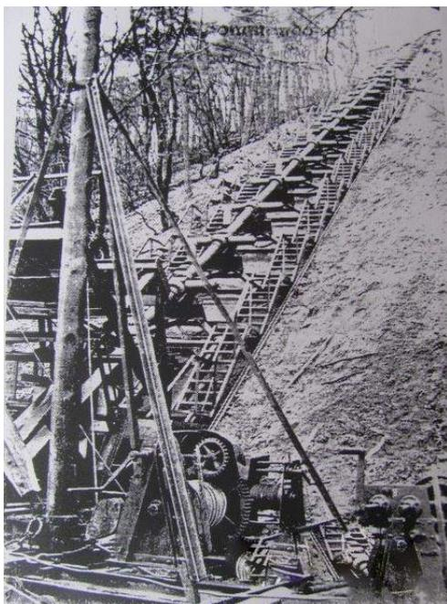
Versuchsrohr der Hochdruckpumpe „Fleißiges Lieschen“ hier mit rechtwinklig angeordneten Seitenkammern.
