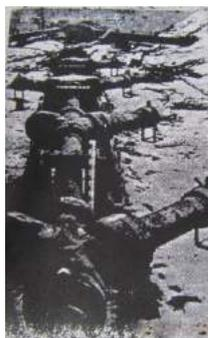
Versuchsrohr der „Hochdruckpumpe“ mit zerstörten schräg angeordneten Seitenkammern
